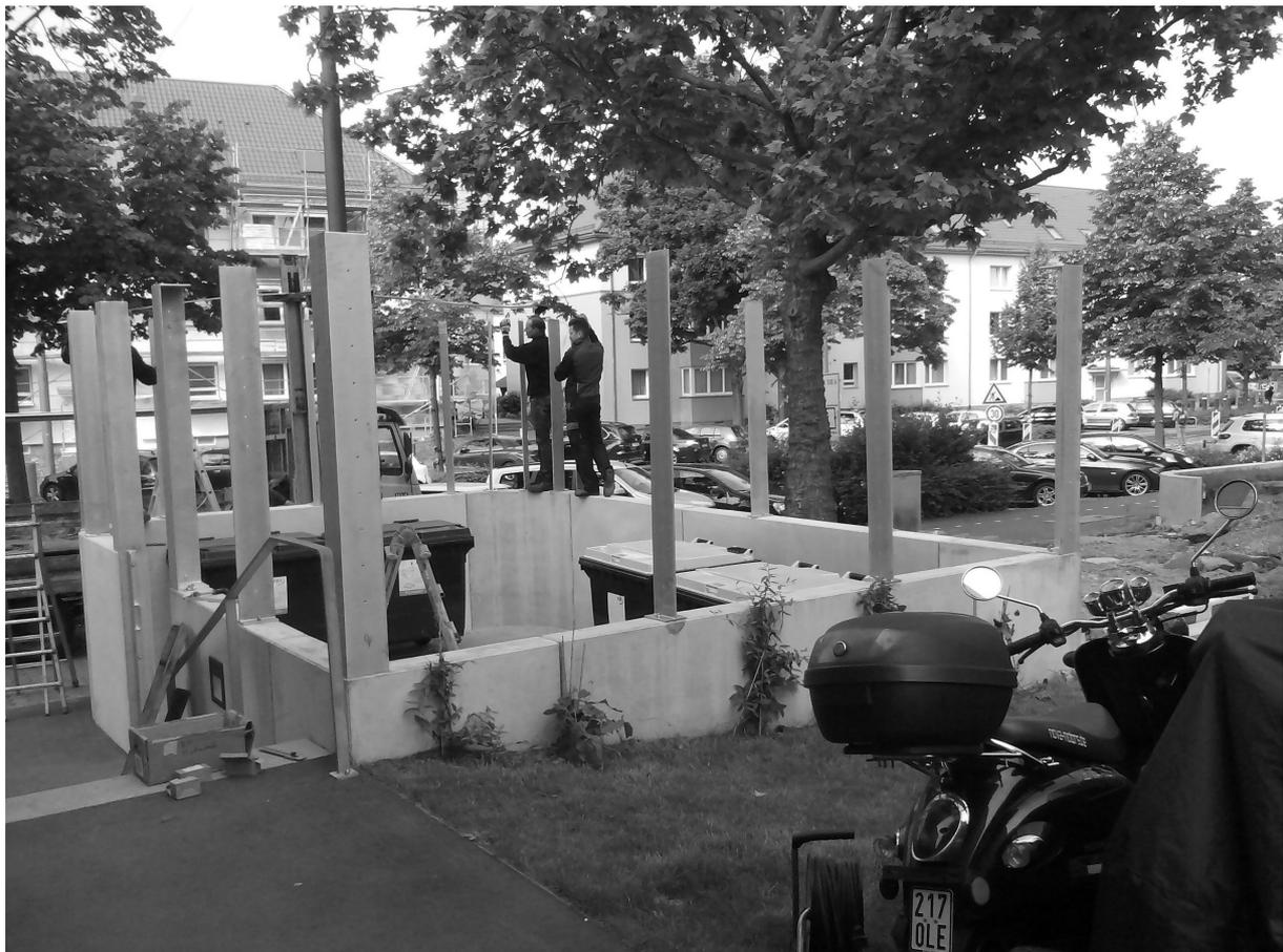
**Foto 13 :** Die Metallkonstruktion, kurz vor der Montierung der Kabeln (mit der Tür und den Flachstahlblechen).
